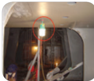
ระบบส่องสว่างชั่วคราวชนิดป้องกันการระเบิด 방폭형 임시 조명등
