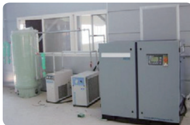
ปั๊มลมแบบสกรูหมุนที่มากับถังบรรจุอากาศ 스크류 타입 공기압축기 및 공기저장탱크
