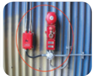
อุปกรณ์แจ้งเตือนเหตุการณ์ไฟไหม้ชนิดป้องกันการระเบิด 방폭형 화재발신기
